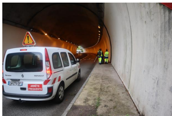
Photo 8 Signalisation préalable du chantier
